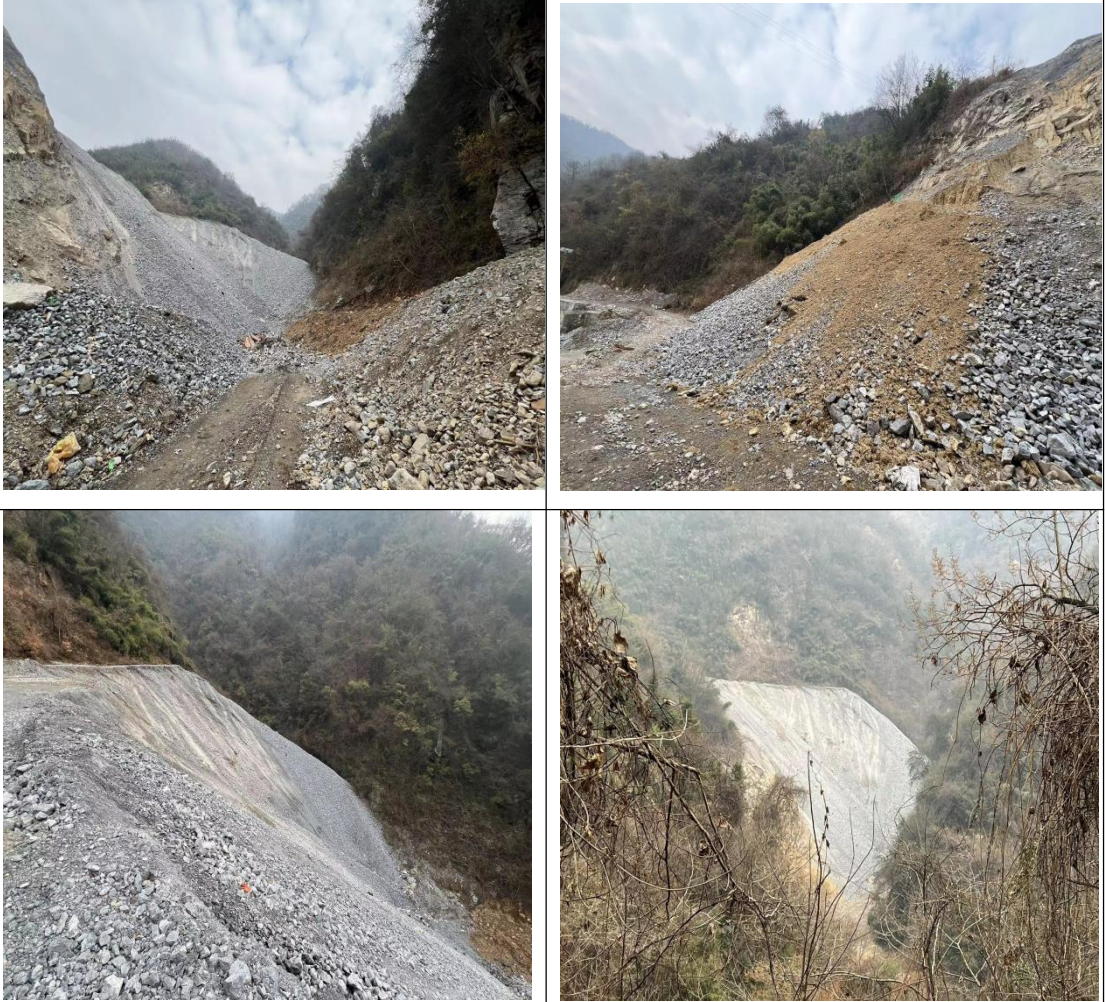
现场影像图（2024年1月20日摄）
